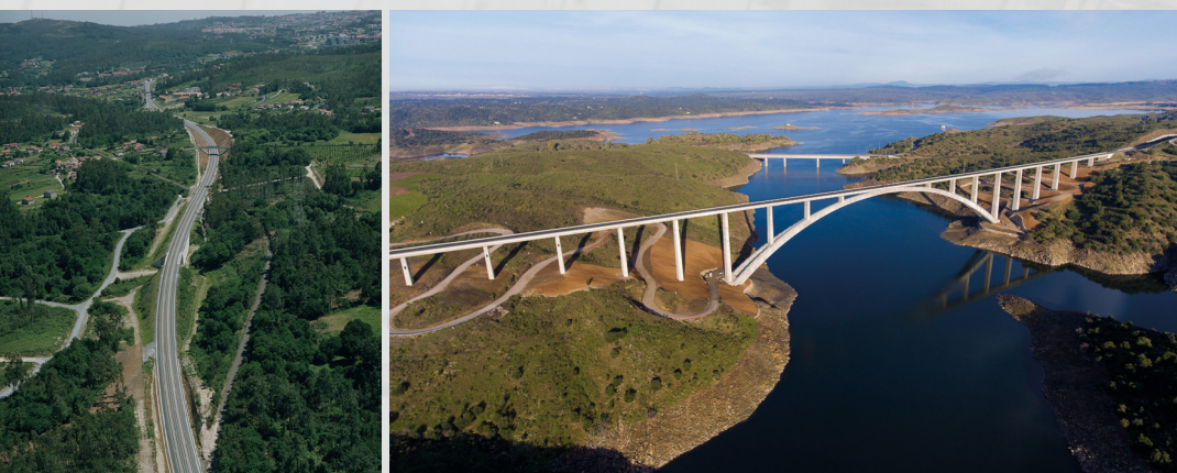
Eje Atlántico de Alta Velocidad. Viaducto sobre el río Almonte (Cáceres).
